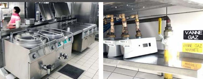
在学校厨房里安装燃气表。
